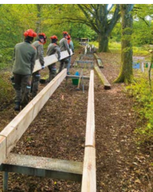
Le démontage du platelage (ci-dessus) et le platelage après travaux (ci-dessous)
