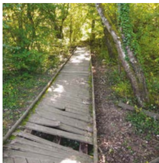
Platelage avant travaux
